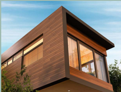
Наружная отделка зданий
