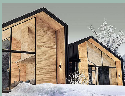
Наружная отделка зданий
