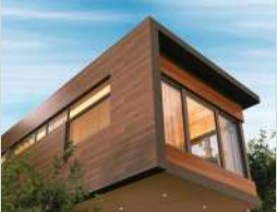
建筑物外部装修
