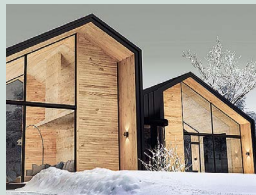
建筑物外部装修
